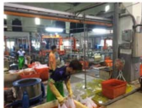
濕製程地坪 Epoxy 防漏
