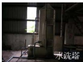
原廢氣處理流程為水洗塔串連活性碳吸附槽
