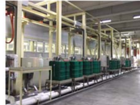
設置地上型管線收集廢水以利管理
