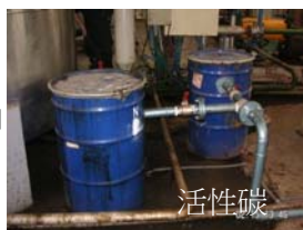
原廢氣處理流程為水洗塔串連活性碳吸附槽
