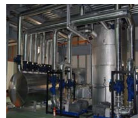
處理設備廢熱回收再利用 200萬卡熱媒油熱交換器
