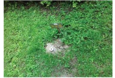
地下油槽設測漏管
