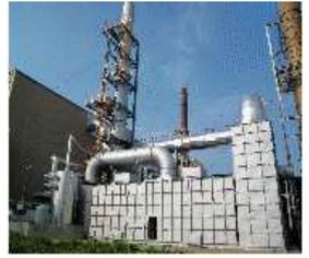
雙槽蓄熱式高溫氧化系統(RTO)處理揮發性有機廢氣
