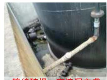
管線破損、有洩漏之虞
