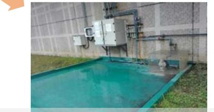
廢水/廢液輸送管線**地上化**、周遭鋪設FRP、設防溢堤及流量監測
