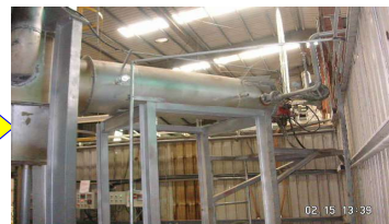
改用焚化設備處理
