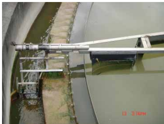
圖 4 浮渣擋板示意
