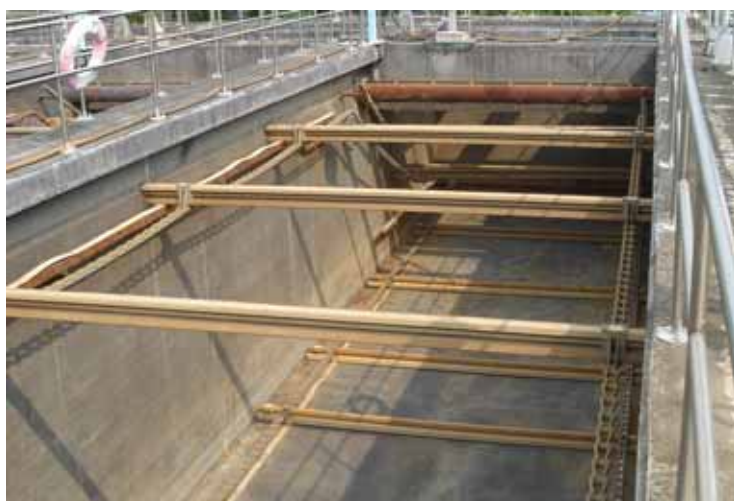
圖 2 矩型刮泥機設備圖
