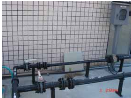
圖 2 現場抽水泵管線安裝方式
