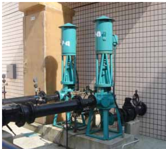
圖 2 廢水泵設備圖
