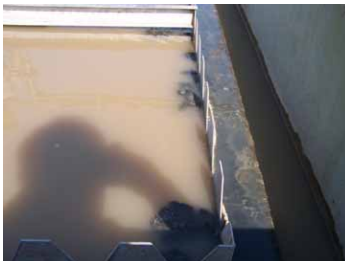
圖 2 沉澱池邊浮渣狀況
