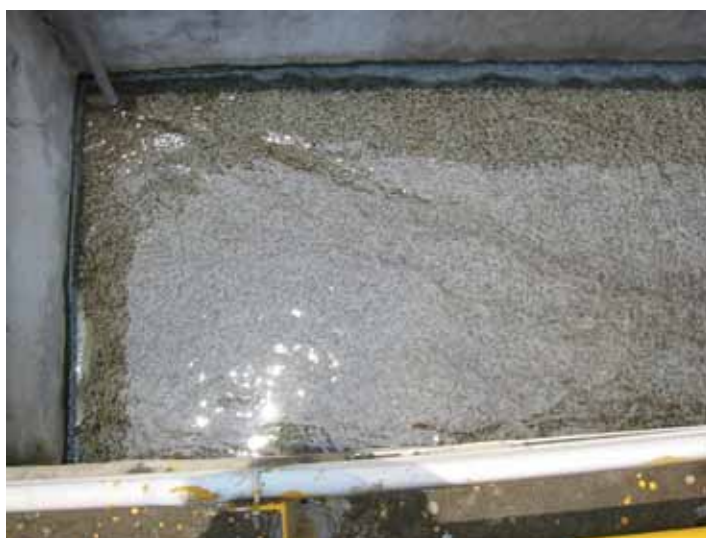
圖 3 膠凝池之混凝膠羽
