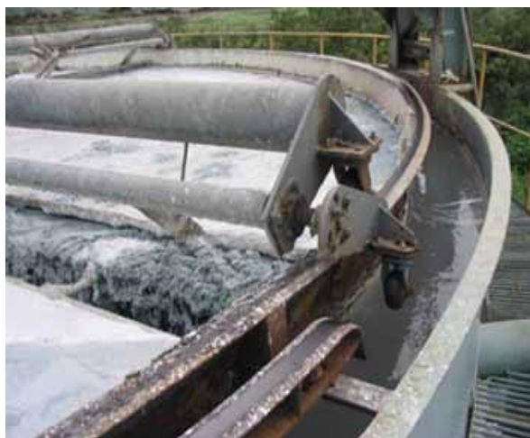
圖 3 浮除刮板上提設施
