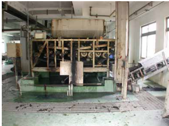
圖 3 帶濾式脫水機
