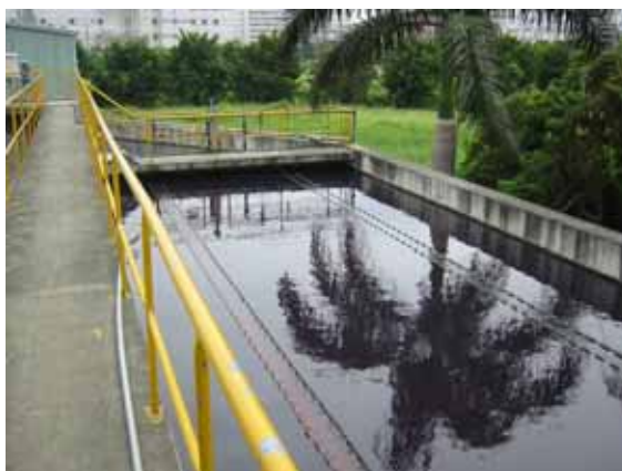
圖 2 物化沉澱池（加傾斜管設備）
