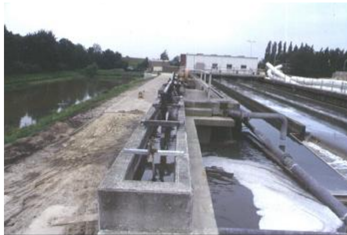
圖 2.1-4 曝氣沉砂池實例
