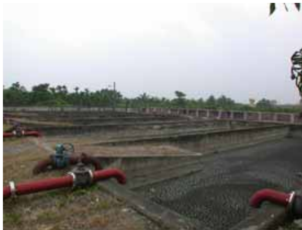
圖 23.1 污泥初始注入污泥干燥床
