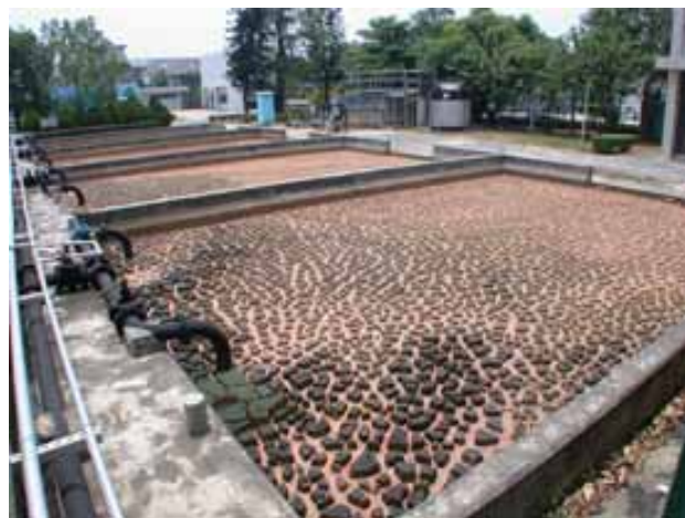
圖 23.2 乾燥龜裂成熟之污泥
