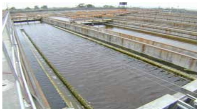
圖 17.2 具溢流堰之矩形二沉池後端
