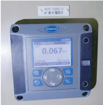
圖 7 UF 產水線上濁度計
