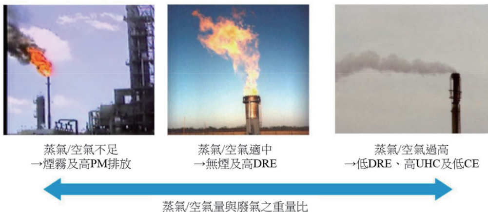
圖 1 燃燒塔使用不同的蒸氣 / 空氣量與廢氣之重量比與燃燒情形 (John Zink Company LLC, 2021)
