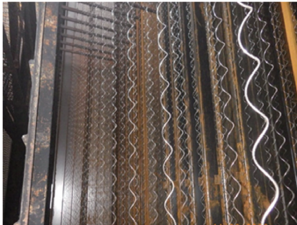
圖 6 新極線安裝後
