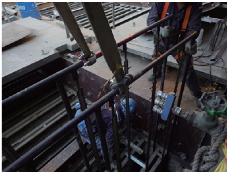
圖 9 新極線框與新極線安裝中
