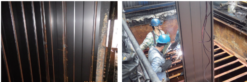
圖 5 新極板安裝後 (左)、新極板安裝過程 (右)
