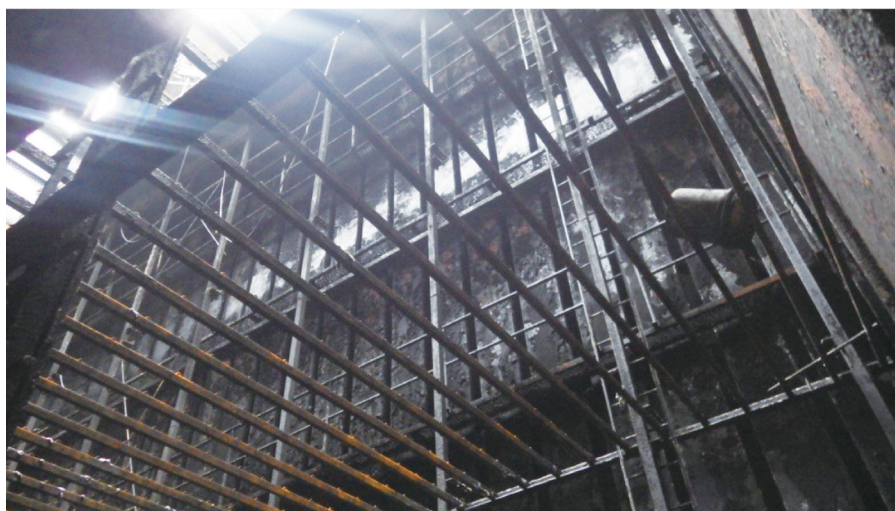
圖 3 舊極板移除後
