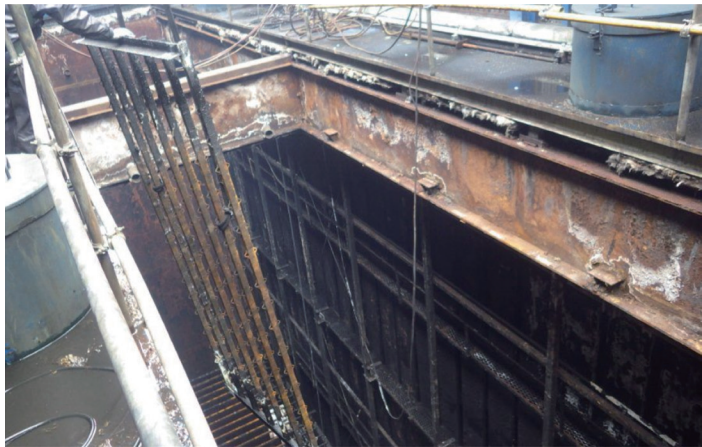
圖 4 舊極線移除後
