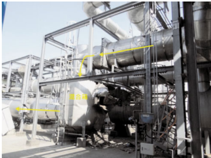
圖 5 混合箱爆炸後之狀況，槽體右側破裂
