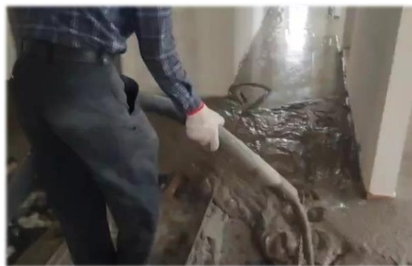
圖 10 本篇研究開發之材料使用管線輸送之情形
