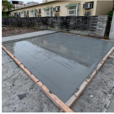
圖 9 本篇研究開發之輕質材料於實地施作情形
