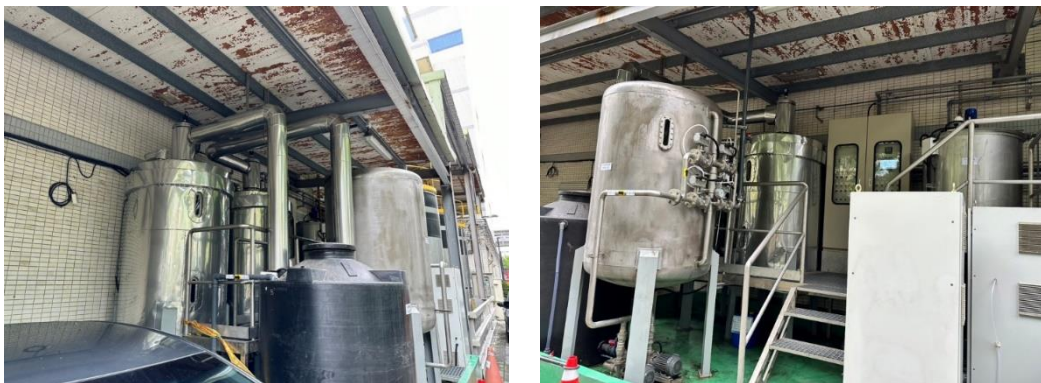
圖 8 實廠廢水 COAC 催化氧化處理流程與照片
