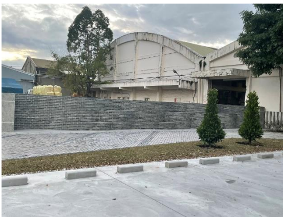
圖 2 華紙公司花蓮廠圍牆試砌與鋪面試鋪照片
