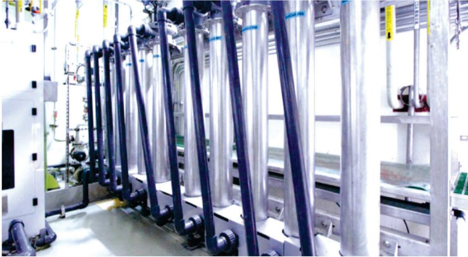
圖 4 某半導體廠之 Recocell 電解回收系統
