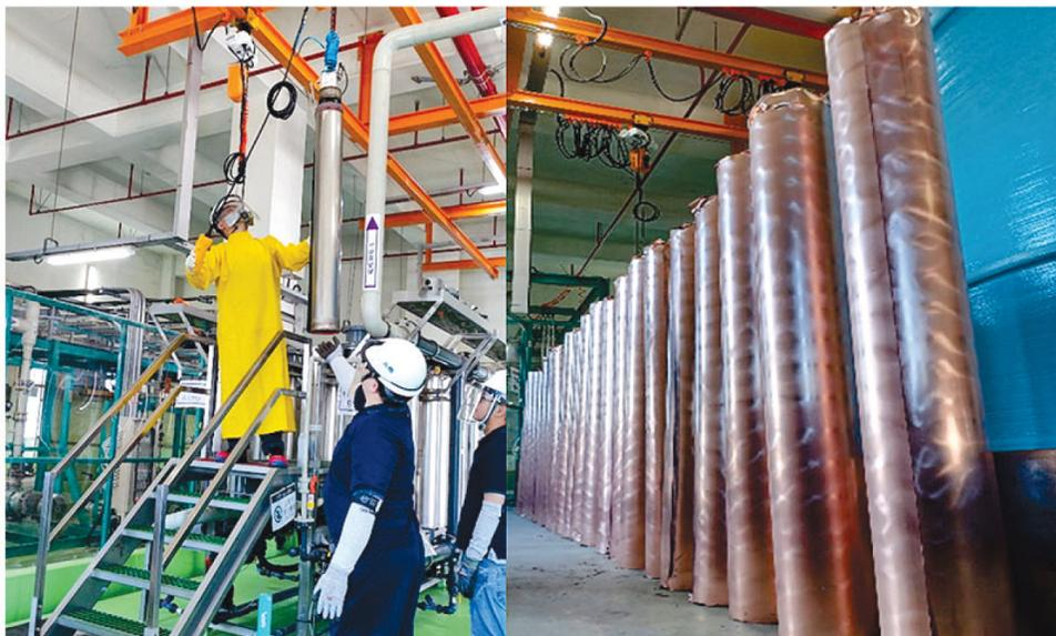
圖 3 某半導體廠之管式電解還原系統
