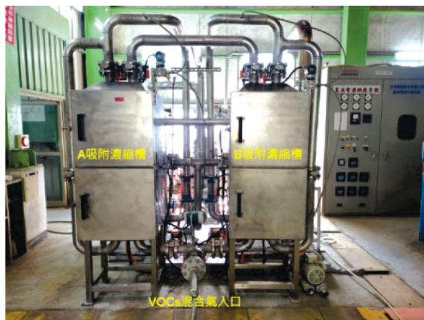
圖 15 吸附濃縮槽的完成照片
