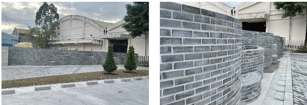
圖 3 華紙公司花蓮廠圍牆試砌與鋪面試鋪照片
