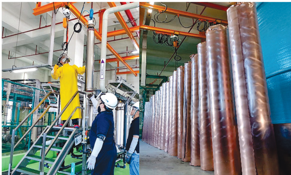
圖 3 某半導體廠之管式電解還原系統
