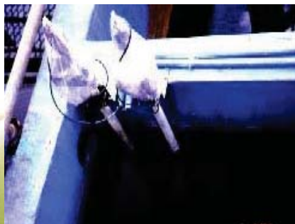
加藥點與監測儀器距離太遠
