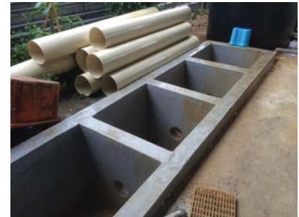
地下貯槽防漏襯砌
