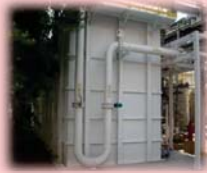
沉澱池變更為脫硝槽
