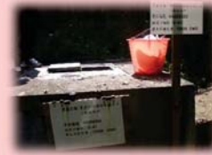
增設AOAO生物處理
