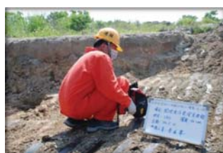
49 開挖區確認無污染
