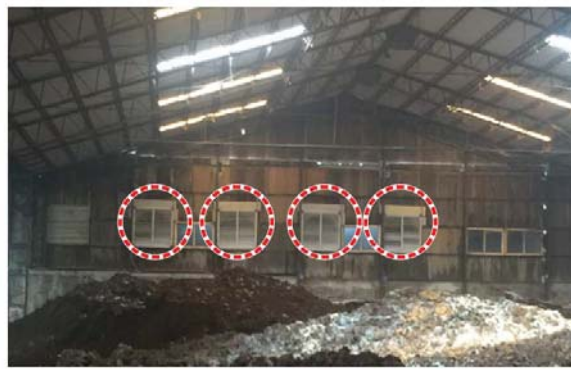
B.排風扇將內部氣體抽至噴霧除臭室除
