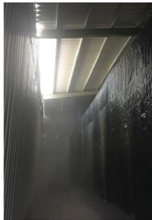
D.噴霧除臭室(排氣隔間)
