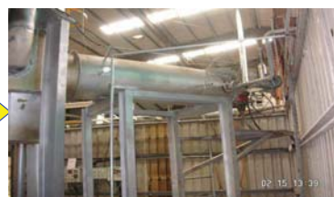
改用焚化設備處理
