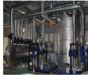
處理設備廢熱回收再利用
