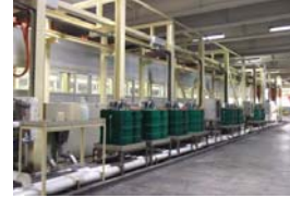
設置地上型管線收集廢水以利管理
