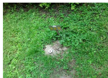
地下油槽設測漏管
