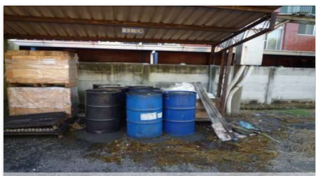
未設置防護措施、鋪面有入滲之虞
