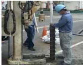
監測井設置及土壤採樣
