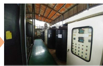
廢水處理設備地上化
