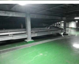
地下共同管溝偵測
