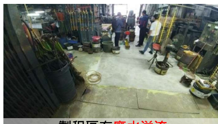
製程區有廢水溢流
