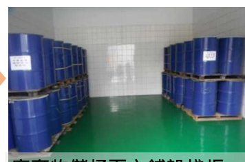
廢棄物儲桶下方鋪設棧板， 廢棄物區EPOXY塗料鋪面
