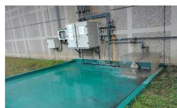
廢水/廢液輸送管線地上化、周遭鋪設FRP、設防溢堤及流量監測
