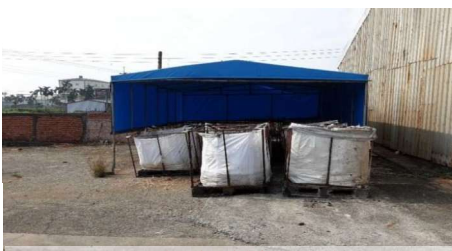
重金屬污泥無完整遮蔽、鋪面破損
