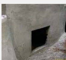
煙囪底座開口
