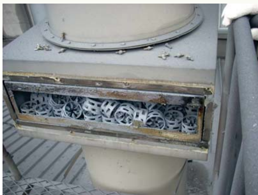
《改善前-管道設填充材》
