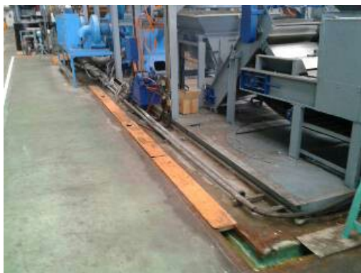
鉻系廢水收集管路
