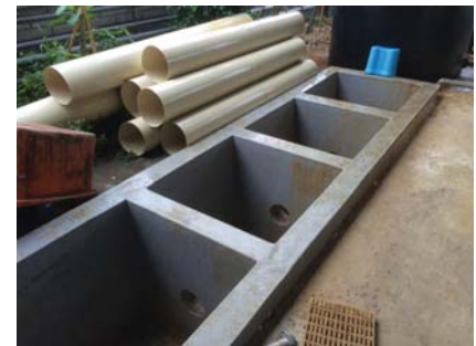
地下貯槽防漏襯砌
