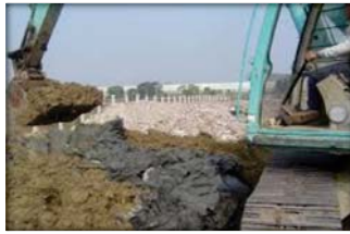
開挖污染土方
