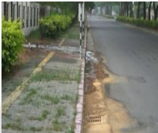
廢污水漫流至雨水下水道
