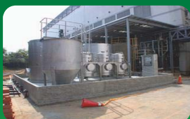
運用高溫菌之高效率 有機污泥現地減量技術
