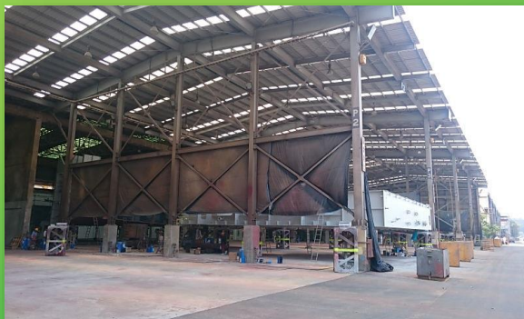
台灣國際造○股份有限公司 -塗裝廠房
